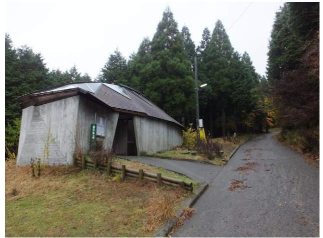
富士見橋トイレ
